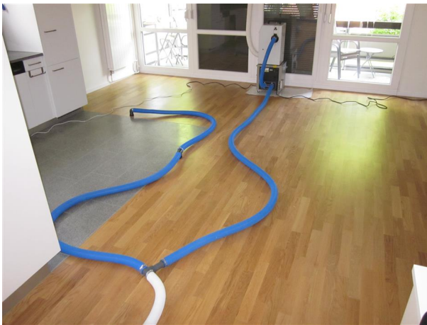
Trocknungseinheit im Wohnzimmer
